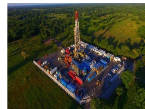
Perforación de pozos
